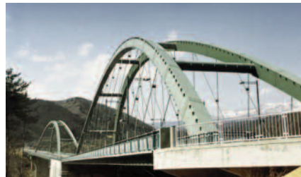
写真3 ハツ場ダム 長野原大橋「めがね橋」デザイン
