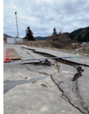
写真14 亀裂でめくれ上がった駐車場舗装
