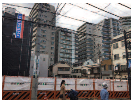
⑨更地（工事中）
